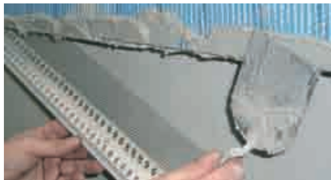
5/ Riempimento con collante Posizionare il profilo e annegare la sua retina
