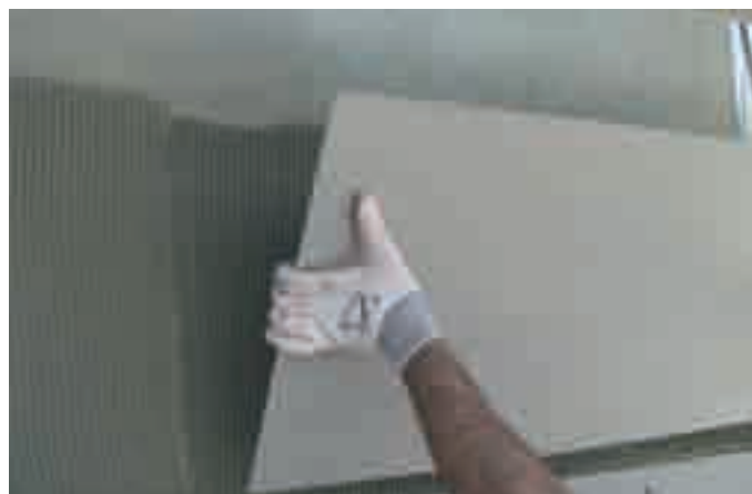
7/ Incollaggio KERLITE PLUS
