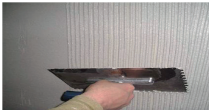
1/ Stesura Collante Con spatola dentata in senso verticale
